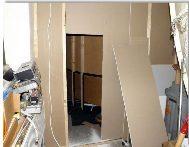
En öppning för att kunna installera en AC i simulatorm.
