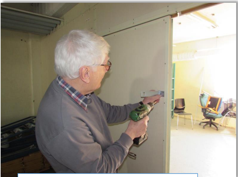
Göran borrar för att montera ett hänglås.
